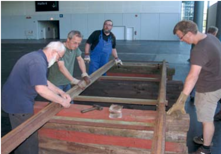
Die Gleisbaurolle im Außeneinsatz: Bau der Laderampe für die Franzburger Garnitur in Halle 5 der Messe Bremen. Bremen, 31. August 2016, Foto: Dennis Mellerowitz
