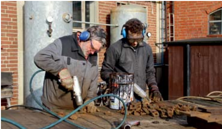
Wiederverwendbares Kleiseisen und Platten für die Weiche 2 in Heiligenberg werden von Robert Angerhausen und Richard Wilkening genadelt. 17. Februar 2018
