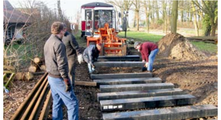
Im nächsten Schritt wurden die Schwellen im Planum ausgelegt. Bernhard Öhler und Jürgen Hunold legten sich mächtig ins Zeug. Foto: DM
