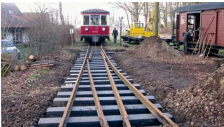
Am selben Abend waren dann Schwellen und Schienen schon grob ausgelegt. Am nächsten Tag ging es weiter mit dem Bohren der Schwellen und Verschrauben der Weiche. Foto: DM
