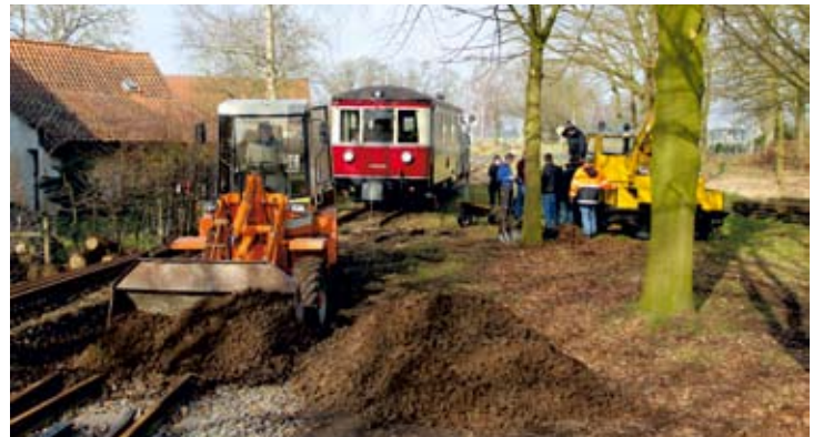
Nun konnte Ralf Hormann mit dem Radlader das Planum zum Verlegen der neuen Schwellen herstellen, was der Rotte viele Stunden Schaufeln sparte.
