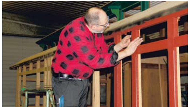
In der Wagenwerkstatt hatte Bernd Fütting Platz zum Arbeiten. Die Arbeiten am Wagen 16 sind derzeit nur „Lückenfüller“, aber Stück für Stück geht's voran. 24. Februar 2018
