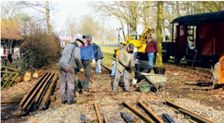
Die Schienen waren weg, Robert Angerhausen und Ralf Hormann sammelten Kleineisen und Platten ein, Jens Böcker begutachtete derweil den Zustand des Materials.
