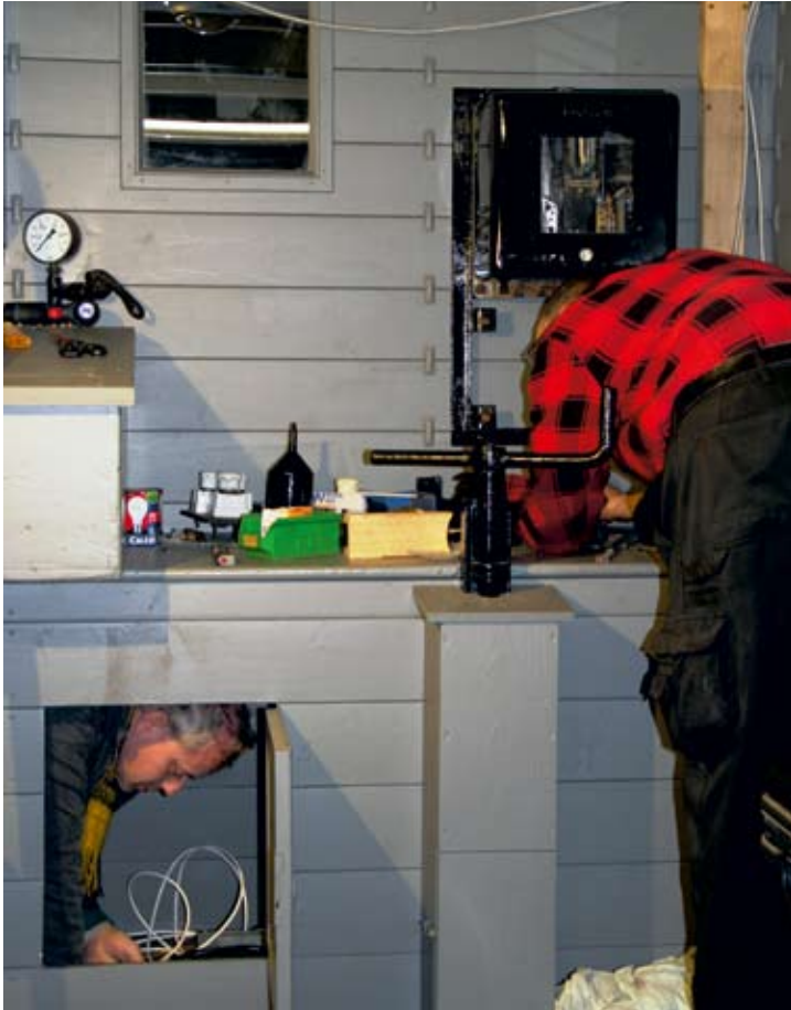
Den anstrengendsten Elektriker-Part beim Verkabeln hatte Patric Stege, der sich im Batterie-Abteil des Packwagen 51 regelrecht herumdrückte. 24. Februar 2018
