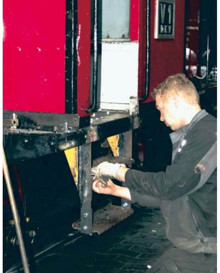
An V 1 „Rappelkiste“ war Matthias Jülke nach Änderung der Druckluftanlagen dabei, die Aufstiegstritte neu zu bauen nach altem Schmalspurbild. 18. Februar 2018
