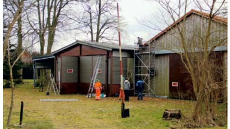
Trotz der Minusgrade pflegten DEV-Aktive die Hallen in Heiligenberg und bauten dafür Gerüste und Leitern auf. 17. März 2018
