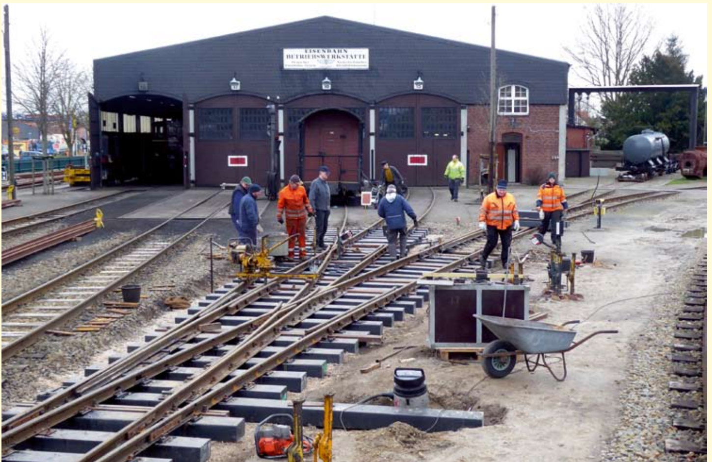
Am Freitagmittag ein Blick über die fortschreitende Weichenbaustelle: Vom erhöhten Standpunkt aus wirkten die fleißigen Aktiven viel kleiner... Bruchhausen-Vilsen, 21. Februar 2020. Foto: Robert Angerhausen
