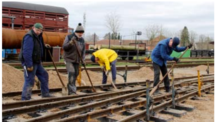
Nach dem Einbringen der Kiesbettung wurde von Hand gestopft. Hier schaufelten und „paddelten“ Holger Post, Robert Angerhausen, Mirko Fischer und Albrecht Lind. 22. Februar 2020, Foto: RM
