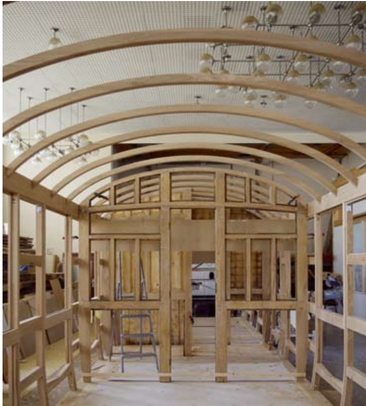
Im März 2020 war die Rekonstruktion des Holzaufbaus von Wagen Nr. 7 in einem Fachbetrieb im erzgebirgischen Zwönitz schon weit fortgeschritten. Foto: Tischlerei Veikko Hübner
