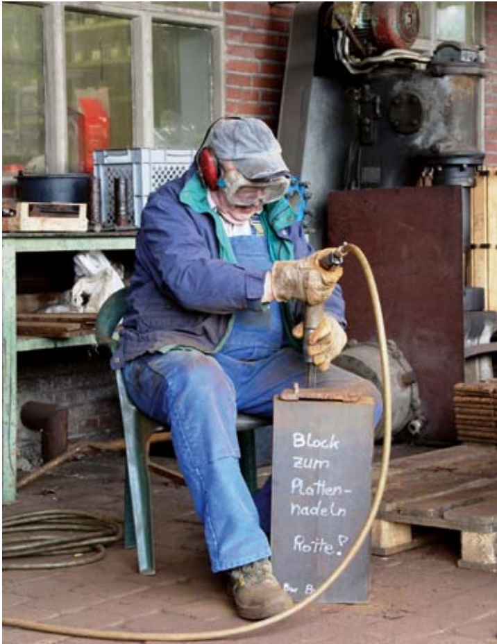
Gerd Schrammen war unermüdlich beim Entrosten der Unterlagsplatten von Weiche 13/14 mit dem Druckluftnadel im Einsatz. 21. Februar 2020, Foto: RM
