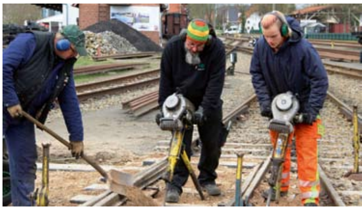
Anschließend wurde mit dem Stopfhammer gestopft: Jürgen und Max Hunold stopften, Holger Post sorgte für ständigen Nachschub an Bettungskies. 22. Februar 2020, Foto: RM
