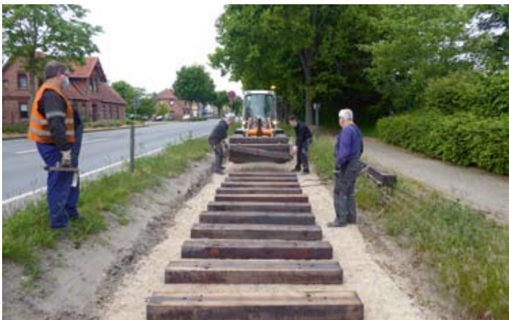
Nach dem Mittagessen bringt Ralf Hormann die neuen Schwellen per Radlader, Lars und Nils Böcker legen sie aus und Dennis Mellerowitz und Joachim Gorr sorgen für die richtigen Schwellenabstände.
