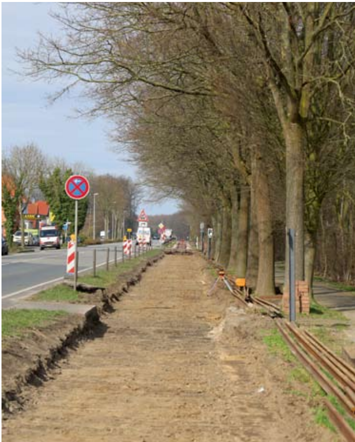
„Still ruht(e) die Baustelle“ in Asendorf nach corona-bedingter Einstellung der Arbeiten. Blick Richtung Arbste, 17. März 2020. Foto: Dr. Thomas Schwerdtfeger
