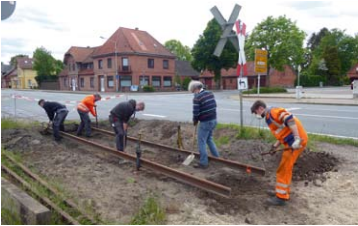
Seit Mitte Mai darf an der Eisenbahn-Infrastruktur der Museums-Eisenbahn Bruchhausen-Vilsen – Asendorf wieder gearbeitet werden: Schwellenwechsel am Asendorfer BÜ Essener Straße.
