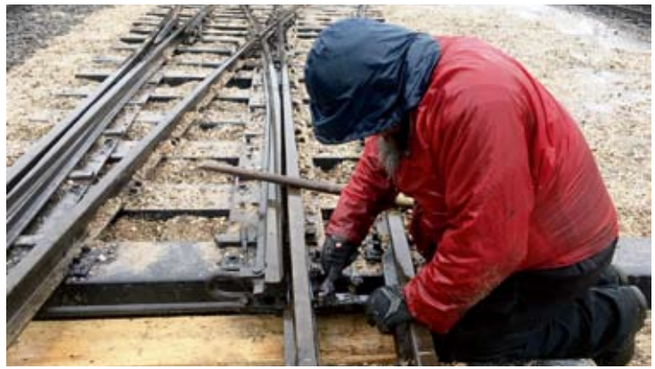
Jürgen Hunold bei der Montage der Weichenstellhebel bei norddeutschem „Schietwetter“. Nun kann Weiche 13/14 wieder befahrbar gemeldet werden. 23. Februar 2020, Foto: Jens Böcker
