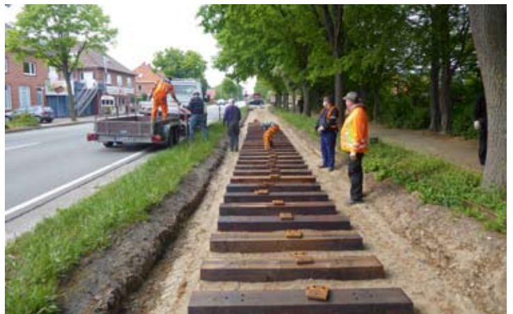
Das Kleineisen wird bereitgelegt, dann können die Schienen wieder montiert werden. Ab Pfingsten soll der Museumszug wieder nach Asendorf fahren! 16. Mai 2020. Alle Fotos: Robert Angerhausen
