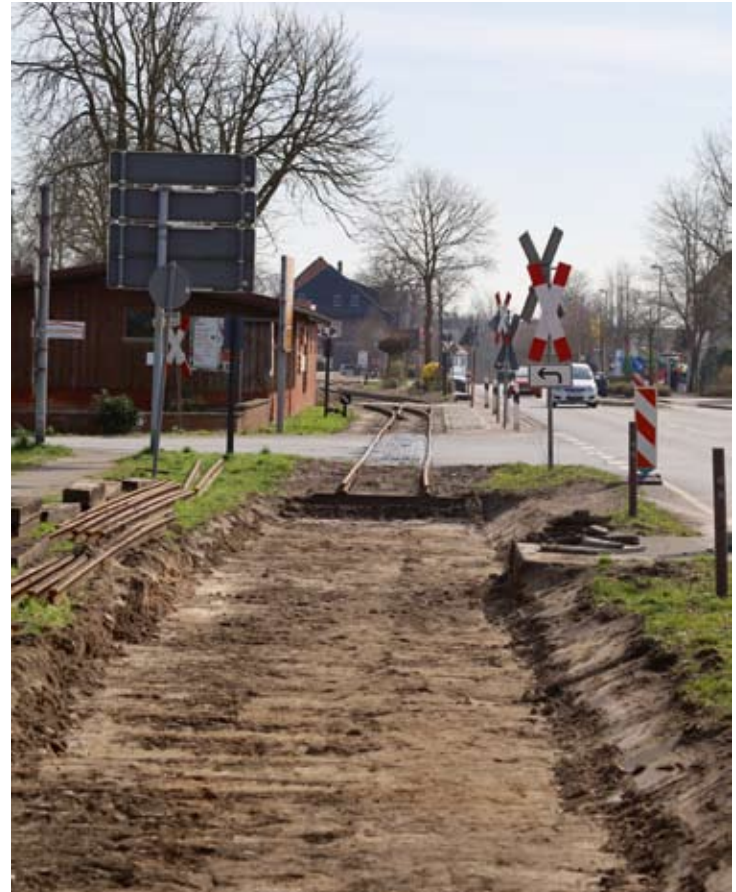
Blick Richtung Asendorf: Das Planum war schon geschoben, die Schienen sind gebohrt. Nach acht Wochen Pause geht es jetzt weiter! 17. März 2020, Foto: Dr. Thomas Schwerdtfeger
