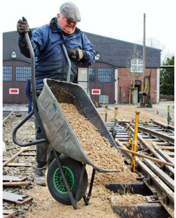
Nach Montage der Doppelweiche 13/14 musste die Bettung teilweise mit der Schubkarre verteilt werden. Hier Joachim Gorr beim Abkippen einer Ladung Kies. 22. Februar 2020, Foto: RM
