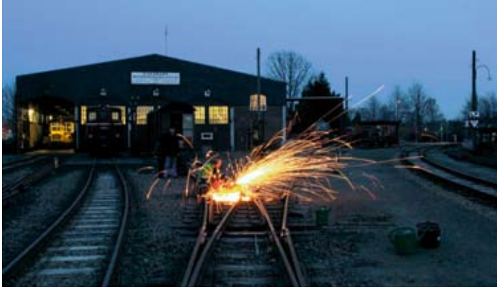
Funkenregen beim Trennen der Fahrschienen an der Doppelweiche 13/14 vor der Fahrzeughalle. Es wurde bis in die Dunkelheit gearbeitet. 15. Februar 2020, Foto: RM
