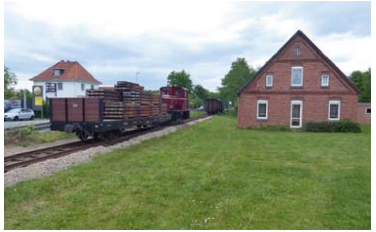
Der erste (Arbeits-)Zug seit dem Lockdown wegen COVID-19 bestehend aus Diesellok V 3 und Güterwagen 123 erreicht die Gleisbaustelle kurz vor Asendorf und bringt neue Schwellen.
