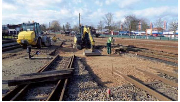
Am Montagmorgen wurde das Planum der Doppelweiche vor der Fahrzeughalle mit dem Radlader geschoben, danach konnte der Wiederaufbau beginnen. 17. Februar 2020, Foto: Robert Angerhausen
