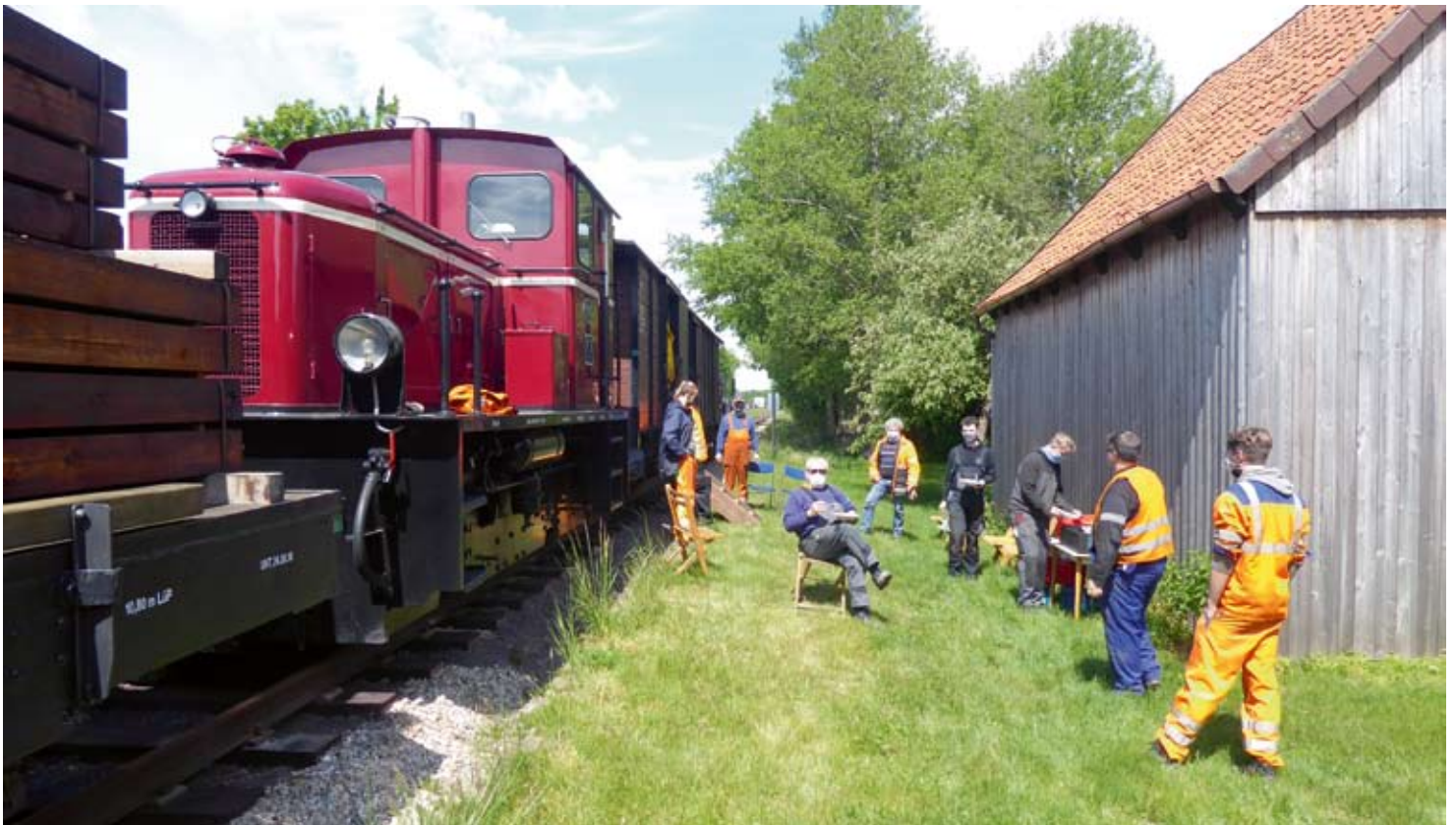
Alle im Gleisbau Arbeitenden tragen Mund-Nasenschutz und halten während der wohlverdienten Mittagspause einen angemessenen Mindestabstand zueinander ein. Trotzdem schmeckt's!
