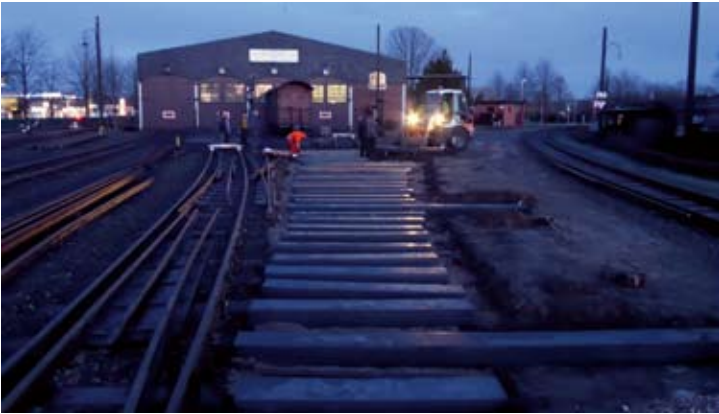
Gearbeitet wurde bis in die Dunkelheit, dann waren die neuen Schwellen für die Weiche 13/14 im Bf Bruchhausen-Vilsen ausgelegt. 17. Februar 2020, Foto: Robert Angerhausen
