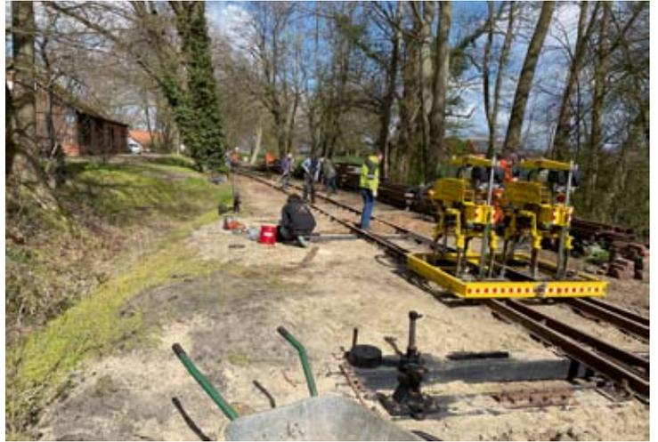
Am 13. April sind die neuen Schwellen schon verbaut und der Gleisrost wieder fertig montiert. Hier sind die Aktiven gerade dabei, die Sand-Kies-Bettung wieder aufzufüllen. Anschließend kann die Stopfmaschine die Schwellen stopfen. Auch die Stellbockschwellen der folgenden Weiche wurden mit erneuert.
