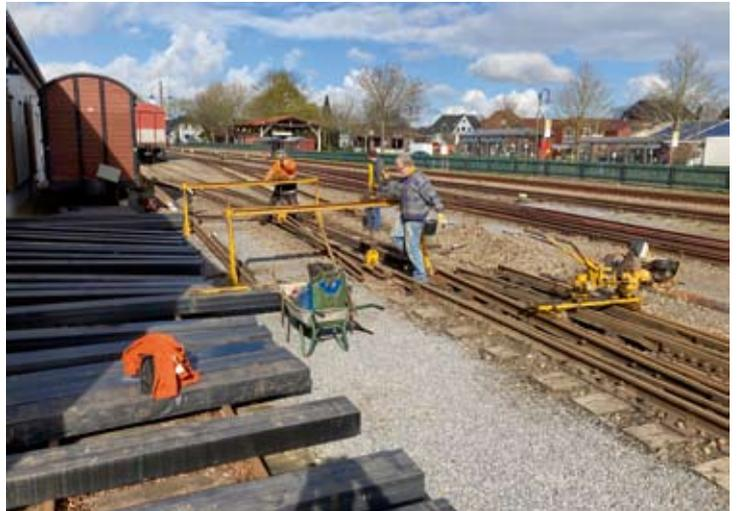
Kaum ist man in Heiligenberg fertig, geht es gleich am folgenden Tag weiter am Bahnhof Bruchhausen-Vilsen mit der einzigen doppelten Kreuzungsweiche der Museumseisenbahn. Mit Hilfe unserer Schienenumsetzkräne wird das schwere Herzstück am Syker Weichenende herausgehoben.
