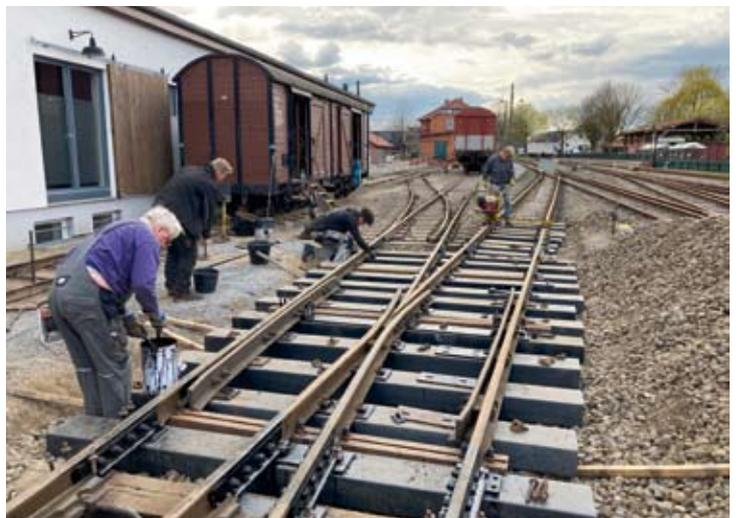
Schon am Folgetag, dem 15. April, sind die neuen Schwellen eingebaut, gebohrt und die Schienen wieder befestigt. Mit Bitumenlack werden die Kleiseisen vor Korrosion geschützt. Jetzt noch Schottern und Stopfen, und dann ist der Syker Teil der DKW wieder betriebsbereit! Sechs Fotos: Lars Böcker
