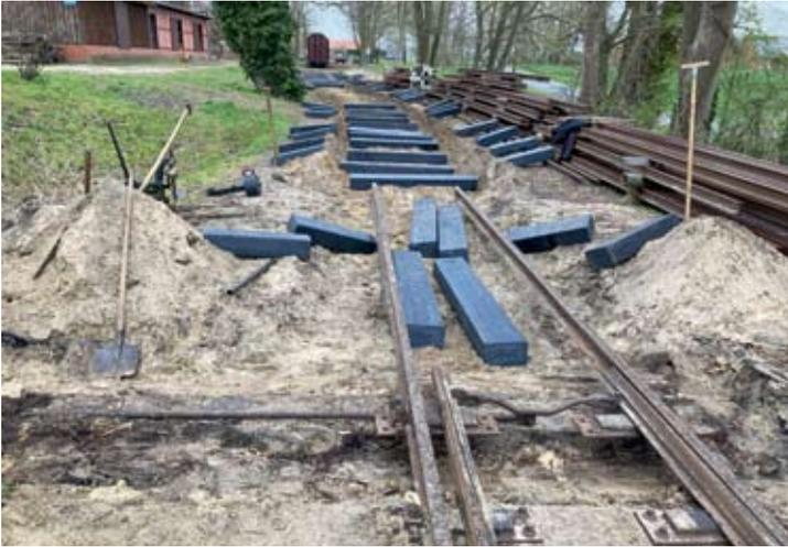
Die Holzschwellen vom Hallenanschlussgleis 3 in Heiligenberg waren völlig abgängig und wurden nun durch haltbarere, aber optisch kaum störende Kunststoffschwellen ersetzt. Zum Teil wurden zur Materialausnutzung Reststücke als Halbschwellen verwendet. Hier der Baustellenstand vom 10. April 2021.
