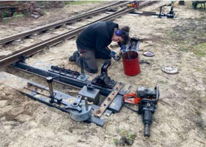
Nils Böcker montiert noch am selben Tag die neuen Weichenstellböcke an der Heiligenberger Doppelweiche: Die erst in Heiligenberg an die Weiche montierten alten, langen Stellhebel mit schwenkbaren Gewichten haben ausgedient.
