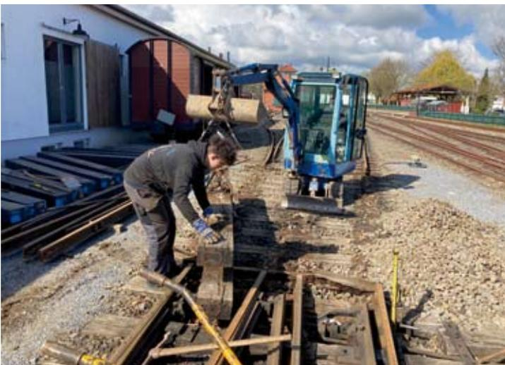
Ralf Hormann hilft Nils Böcker mit einem Minibagger beim Raushieven der maroden Altschwellen. Die Kleiseisen sind schon eingesammelt und bei Gerd Schrammen zum Entrostern. Die neuen Kunststoffschwellen liegen links schon zum Einbau bereit.
