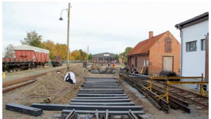
Die neuen Kunststoffschwellen sind fast alle ausgelegt, danach können die Schienen aufgesetzt werden.
