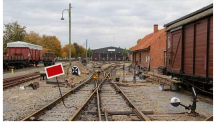
Gegen Nachmittag sind alle Schienen wieder grob in Position und werden montiert, das Weichengestänge fehlt noch.
