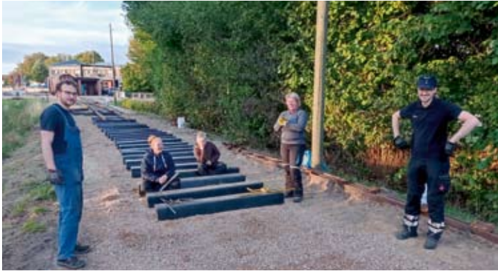
Herbstbaustelle 2022 am Kindermannweg: Nach Herstellung des Planums wurden die neuen Schwellen ausgelegt. Gut gelaunt stellten sich Richard Wilkening, Jessica Hormann, Hannes und Alexandra Hillebrecht sowie Eike Amelung zum Foto., Bruchhausen-Vilsen, 7. Oktober 2022.
