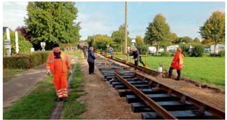
Einen Tag später und am anderen Ende der Gleisbaustelle schien wieder die Sonne. In Höhe des Gartenbahncafés wurden unter den wachsamen Augen von Rotten-Ingenieur Guido die Schienen aufgesetzt. Bruchhausen-Vilsen, 8. Oktober 2022. Zwei Fotos: Robert Angerhausen
