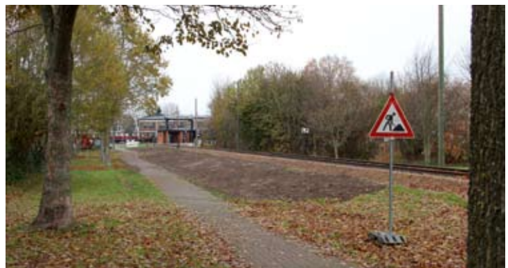
Beim Besuch der Museums-Eisenbahn am ersten Advents-Wochenende war neben dem erneuerten Gleis der Graben von der Gemeinde verrohrt worden, die Baustelle gerade fertig. Bruchh.-Vilsen, 27. Nov. 2022. Foto: RM
