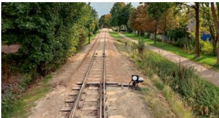
Ein prüfender Blick vom Bauzug auf das erneuerte Streckenstück. Die DEV-Aktiven hatten wieder einmal eine tolle Arbeit abgeliefert! Bruchhausen-Vilsen, 13. Oktober 2022. Foto: Robert Angerhausen
