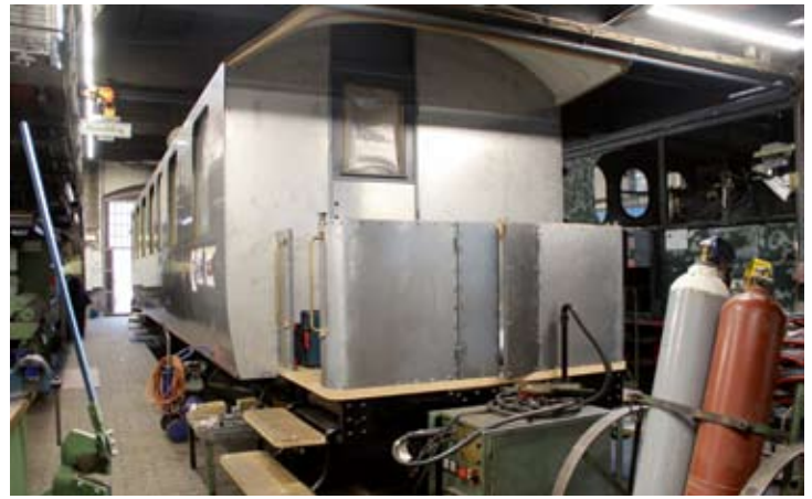
Am Wagen 7 gehen die Arbeiten langsam, aber stetig voran. Die Bühnenverblechung ist fertig, und es geht an den Wagenseiten weiter. Bruchhausen-Vilsen, 26. November 2022. Zwei Fotos: RM
