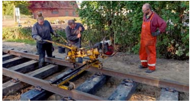
Wenn der Vater mit der Tochter Gleise baut, dann wird das was! Jessica Hormann an der Schraubmaschine, unterstützt von Ralf, warum nur schaute Jens Böcker so nachdenklich? Bruchhausen-Vilsen, 9. Oktober 2022
