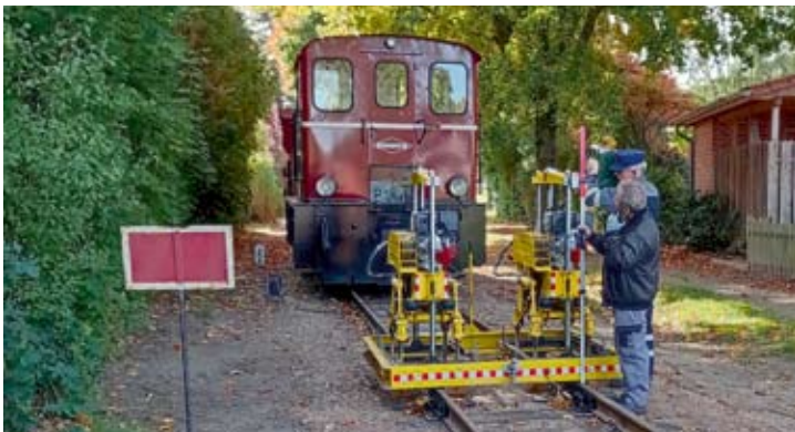
Am Dienstag stand dann auf dem Arbeitsprogramm: Richten der Höhenlage, Stopfen und wieder Kies fahren. Die Stopfmaschine wurde vorbereitet für den Arbeitstag und die V 3 „Ziehel“ stand bereit mit dem Wagen voll Kies. Bruchhausen-Vilsen, 11. Oktober 2022. Zwei Fotos: Robert Angerhausen
