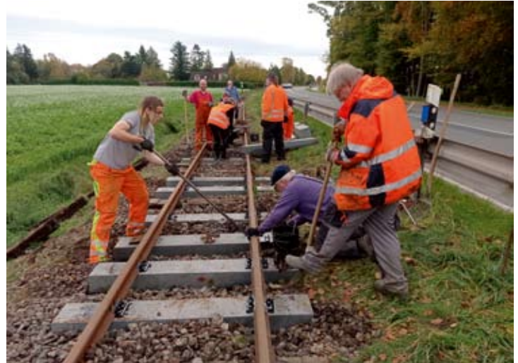
Nach Sperrung der Strecke von Arbste bis Asendorf begann der Einzelschwellenwechsel in der Asendorfer Kurve. Die abgängigen Holzschwellen wurden gegen Kunststoffschwellen getauscht – eine nach der anderen, insgesamt über 90 Stück ... 20.10.2024, Foto: Robert Angerhausen
