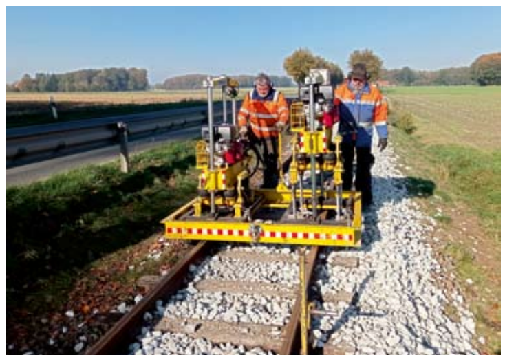
Gestopft wurde dann noch eine ganze Zeit. Meter um Meter geht dies mit der Stopfmaschine, die wir nun auch schon seit fast 10 Jahren haben, viel schneller als früher mit den Kraftstopfern. Im Sonnenschein stopften hier Robert Angerhausen und Jürgen Hunold, mit dem Kraftverkehr der B6 im Hintergrund. 24.10.2024, Foto: Slg. Robert Angerhausen
