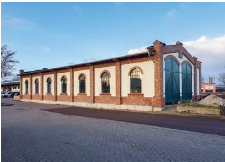
Vor Weihnachten waren die Rohbauarbeiten am neuen Lokschuppen in Bruchhausen-Vilsen abgeschlossen. Von der Straßenseite gesehen fügt sich das neue Gebäude wunderbar in das Bahnhofsensemble ein ...
