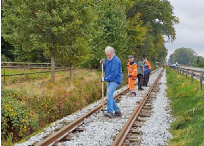
Die Herbst-Bauwoche der Gleisbaurolle begann mit „leichteren“ Tätigkeiten, da noch zwei Sonderfahrten unterwegs waren. Nach den Stopfarbeiten zwischen Bensemans Weg und dem Hp Klosterheide wurde hier der Schotter nach dem Stopfen verteilt. 19.10.2024, Foto: RM
