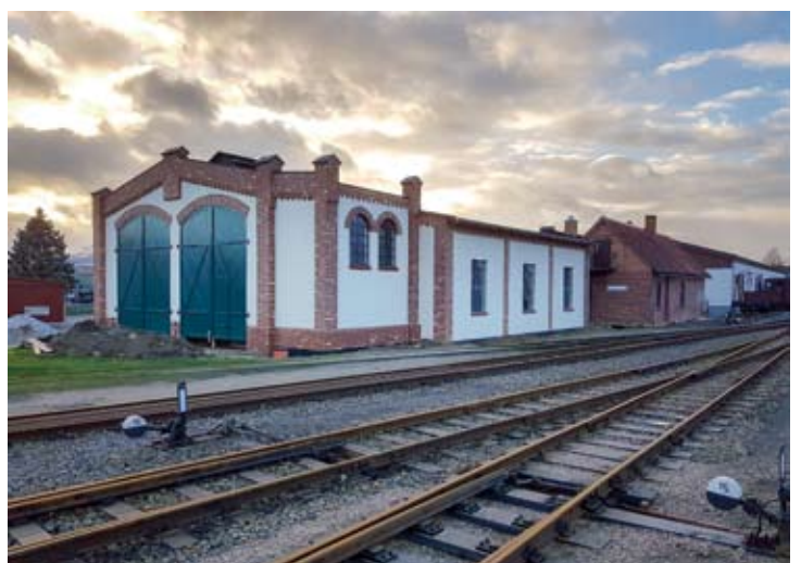
... und auch von der Gleisseite gesehen, vervollständigt der neue Lokschuppen zusammen mit dem historischen Rottenschuppen, der noch renoviert werden muss, das Bahnhofsbild. 20.12.2024, zwei Fotos: Christian Schröder
