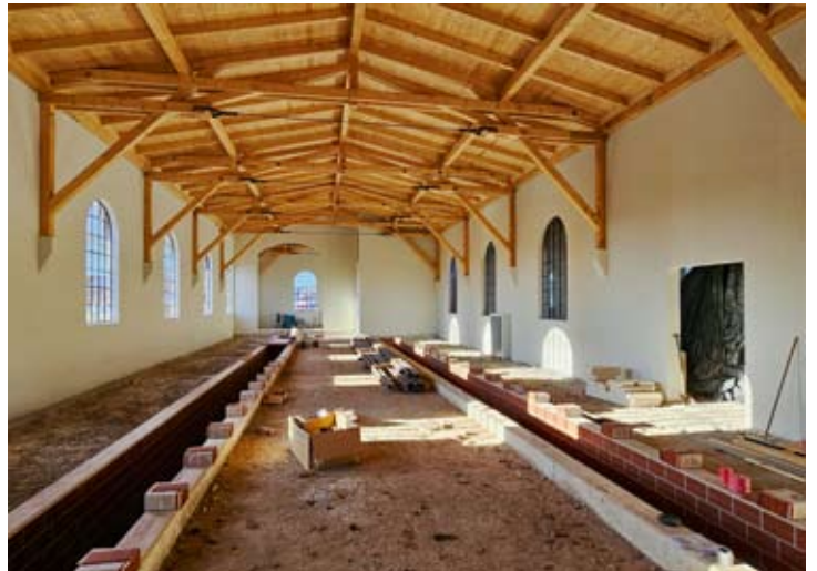
Im Lokschuppen wurden während der Herbstmonate die Fliesen in den Gruben verlegt, nachdem die Arbeiten an den Wänden abgeschlossen waren. Ohne Gerüste und mit den hellen Wänden und der offenen Dachkonstruktion beeindruckt die „Kathedrale der Dampfloks“. 30.11.2024, vier Fotos: RM
