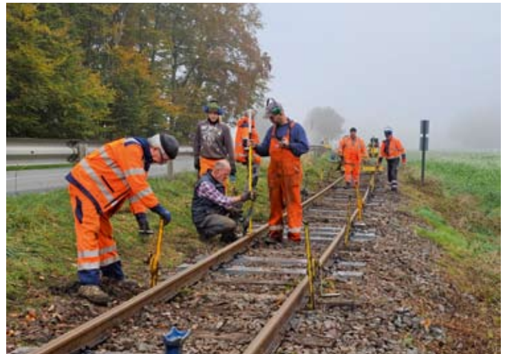
Nach dem Schwellenwechsel wurde das Gleis auf Höhe gebracht. Mit dem Visiergerät wird die Ist-Höhe genommen und die erste Schiene mit Winden hochgekurbelt bis auf Sollhöhe, danach dann die zweite Schiene ausgerichtet. 23.10.2024, Foto: RM
