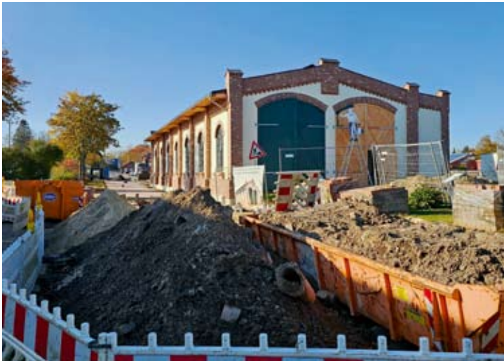
Im Oktober wurde endlich die Gasleitung in der Straße „Am Gaswerk“ umgebaut. Unter Vollsperrung der Straßenverbindung vom RWG-Schuppen bis zum DEV-Parkplatz fanden umfangreiche Erdbauarbeiten statt. Die erforderlichen Umwege sorgten für manchen Unmut. 24.10.2024
