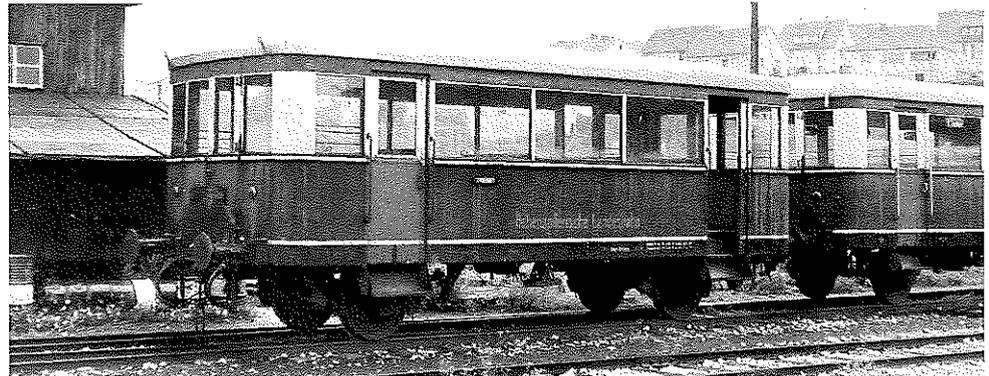
Die beiden ersten Beiwagen der HZL – der VB 11 und VB 12 – waren um ein Fenster kürzer als die Triebwagen und die beiden später beschafften Beiwagen. Hier steht der VB 12 am 19. August 1965 im Bahnhof Gammertingen.
