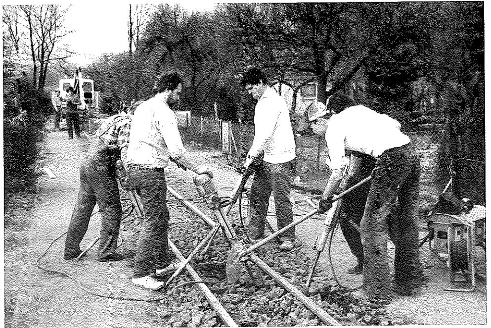
oben: Gleisstopfen an der Verbindungsstrecke durch die Kleingartenanlage. Hier und im Rebstockgelände sind die Gleise ganz im Boden eingelassen, April 1988. Foto: Udo Przygoda
