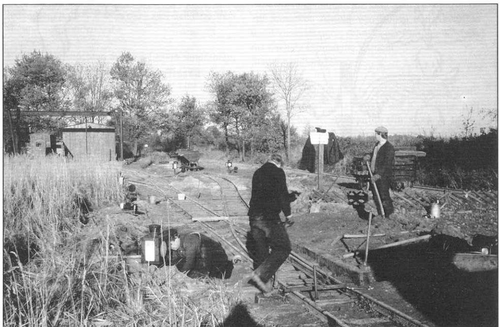
Oben: Vorbohren bereits verlegter Schwellen
