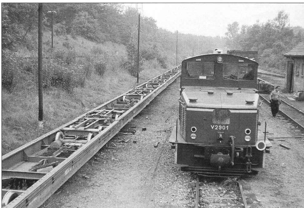
*Oben: Das in mehreren Veröffentlichungen der DB gezeigte Werkfoto vom Lieferzustand, V 29 951 [1], im Vordergrund das Fahrwerk mit den Batteriesätzen*
